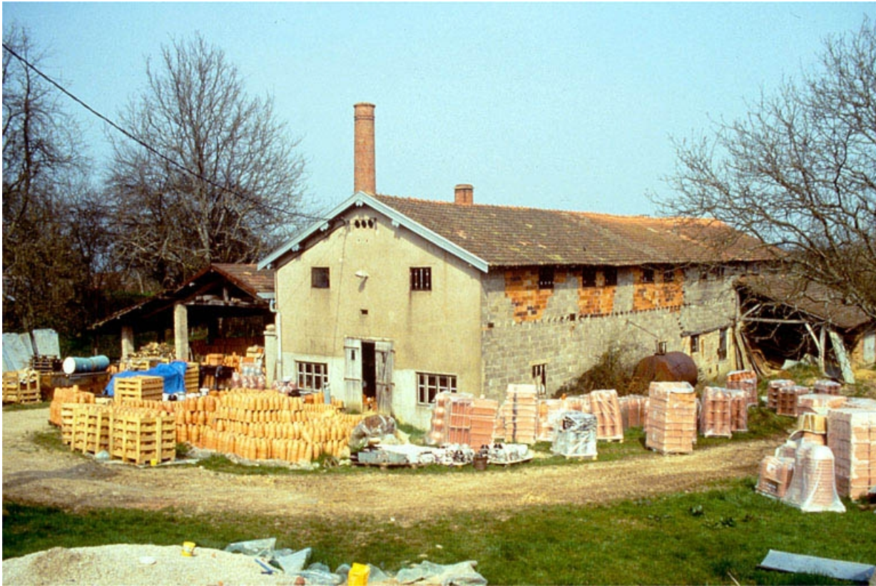
Façades antérieure et latérale droite.
