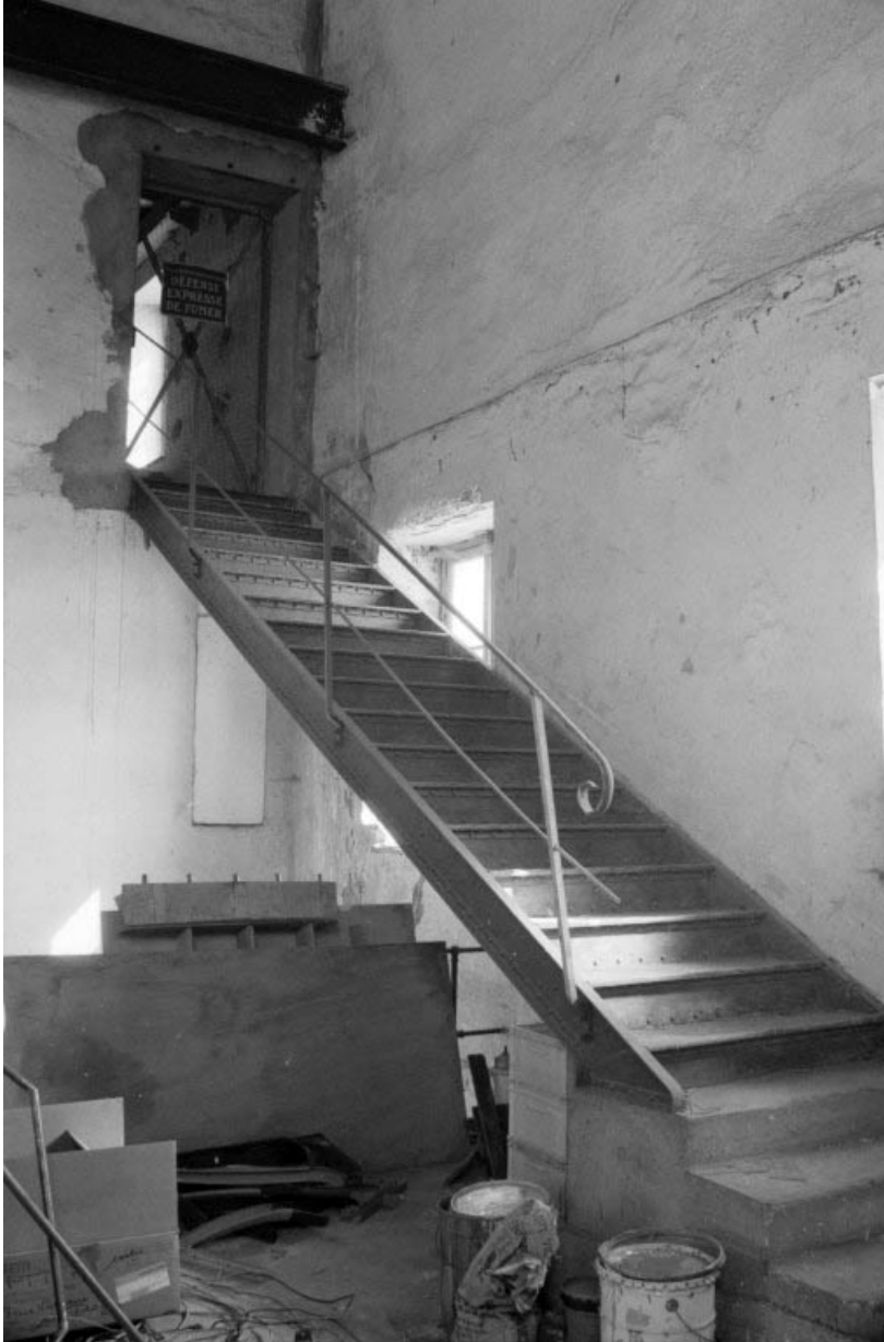
Salle des machines à vapeur (b3) : escalier.
