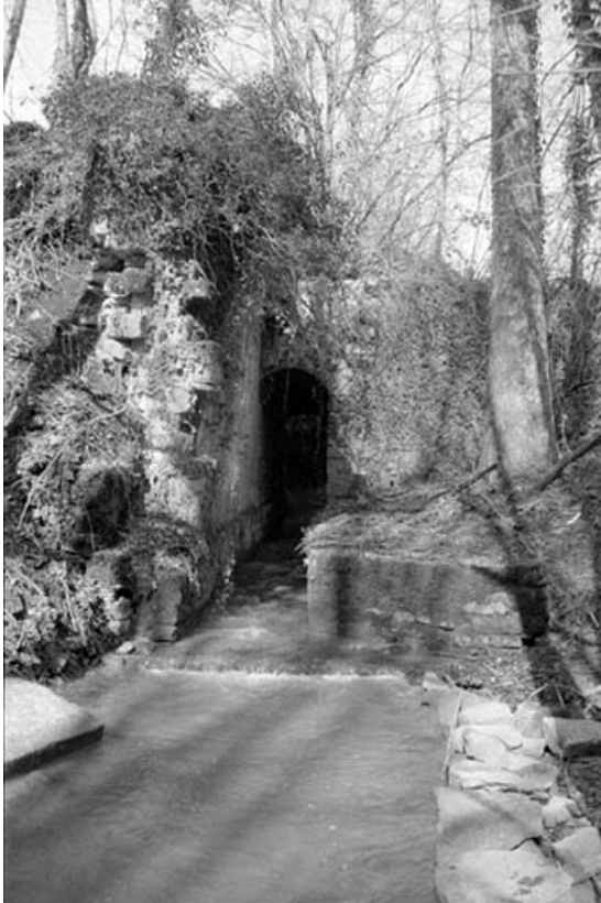
Coursière au débouché du bassin de retenue.
