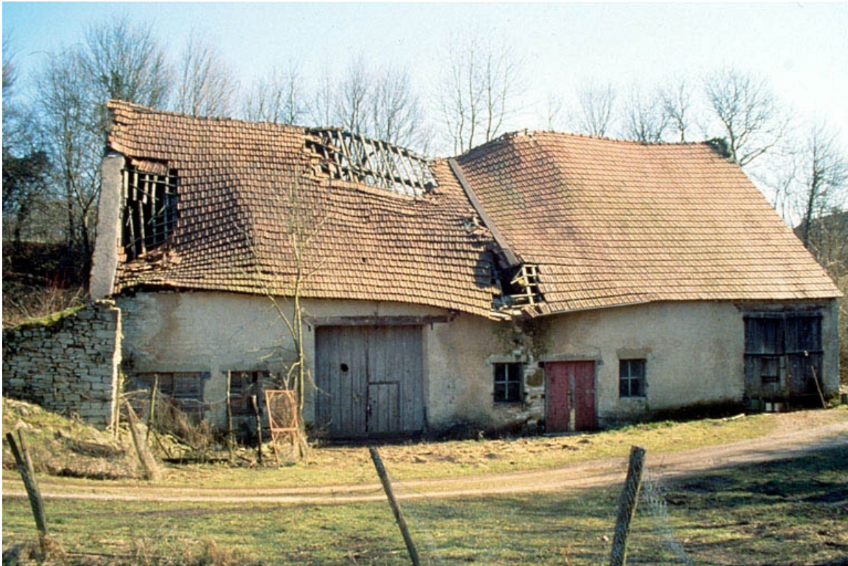
Façade antérieure de l'ancienne halle à charbon.
