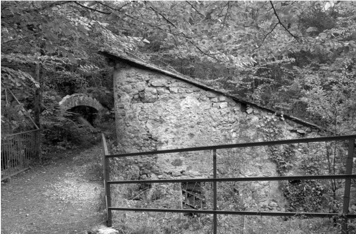
Site de la cascade : bâtiment d'eau.
