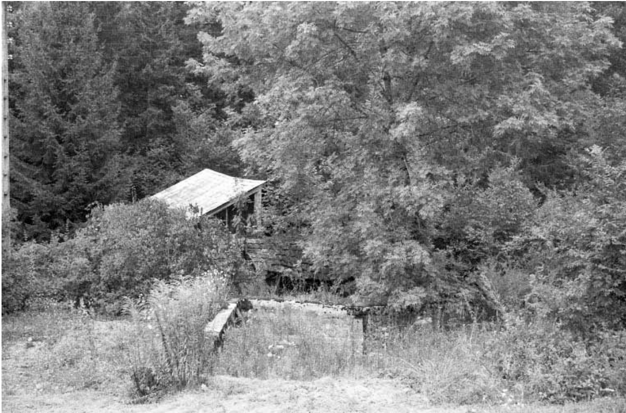
Bassin de retenue et atelier (A).
