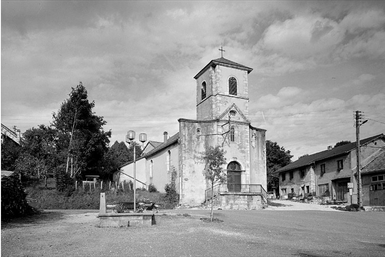
Extérieur : façade ouest et face sud.
