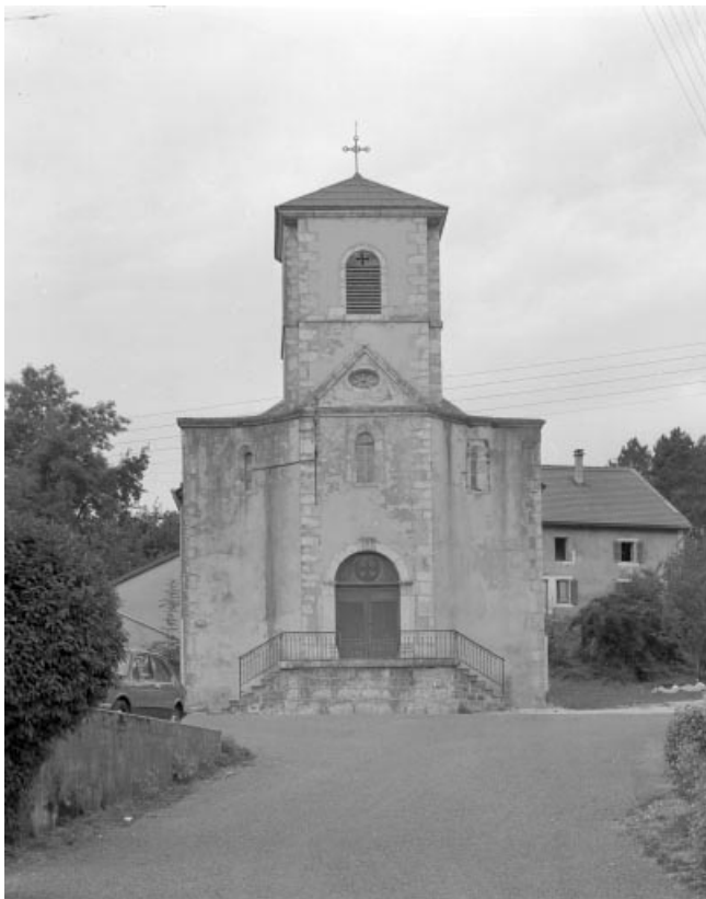
Extérieur : façade ouest.
