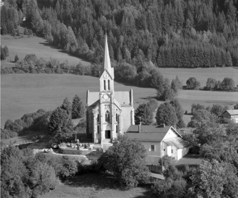
Extérieur : vue générale de la façade ouest.
