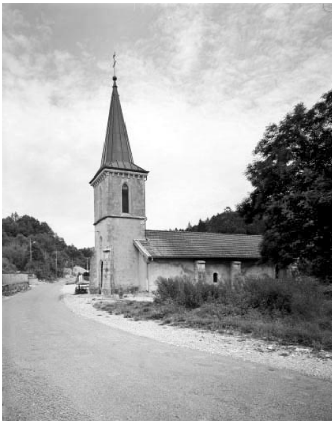
Extérieur : face sud et tour-clocher.
