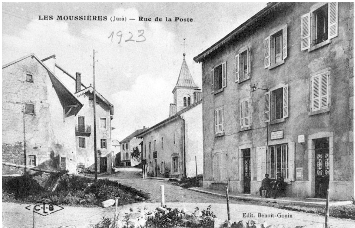
La rue de la Poste. 39, Les Moussières
