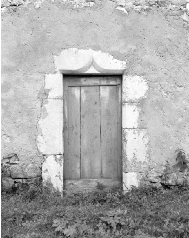
Porte d'accès à l'étable.
