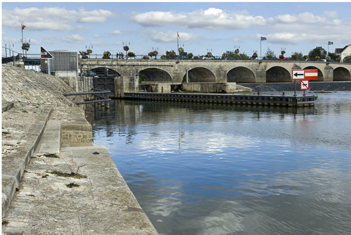
L'écluse, vue aval.
