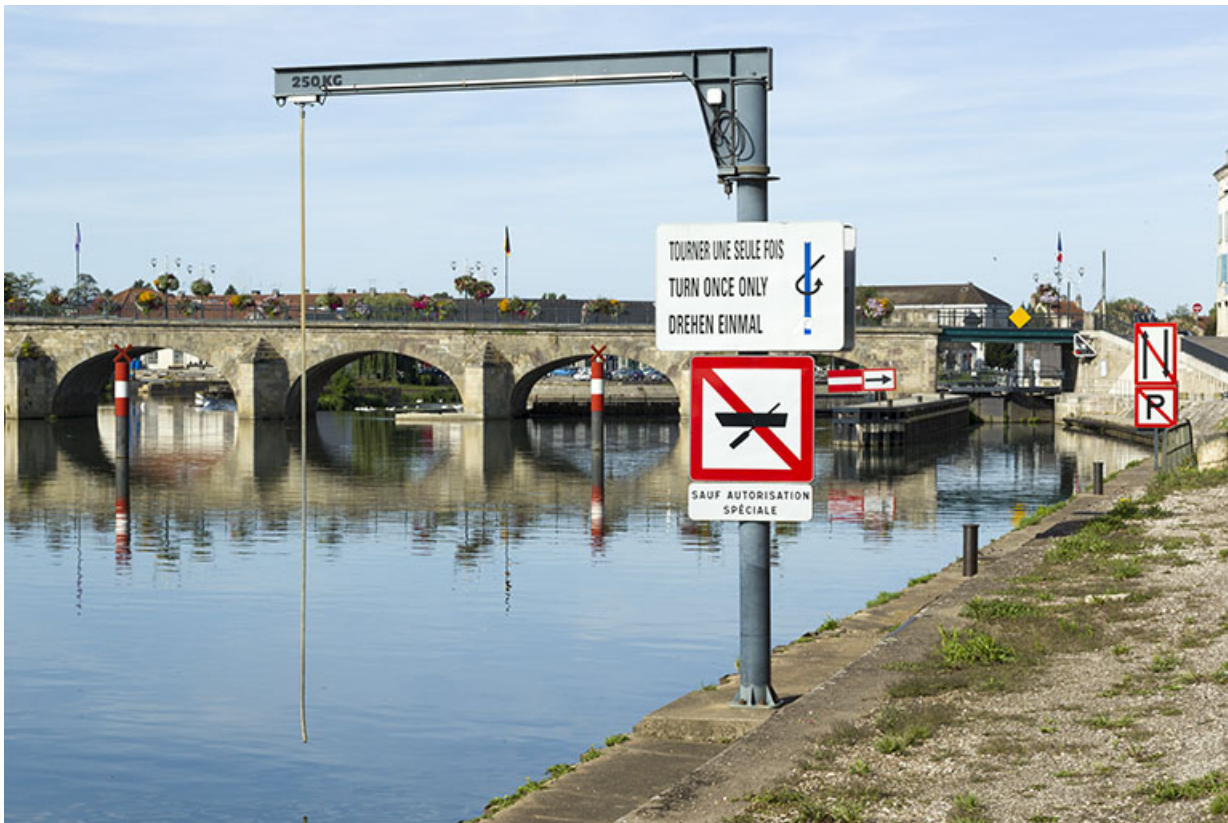
Instrument permettant d'ouvrir l'écluse de manière automatique.
