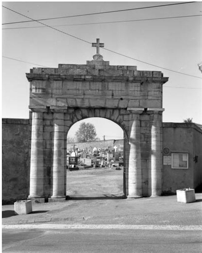
Vue du portail d'entrée : de face.
