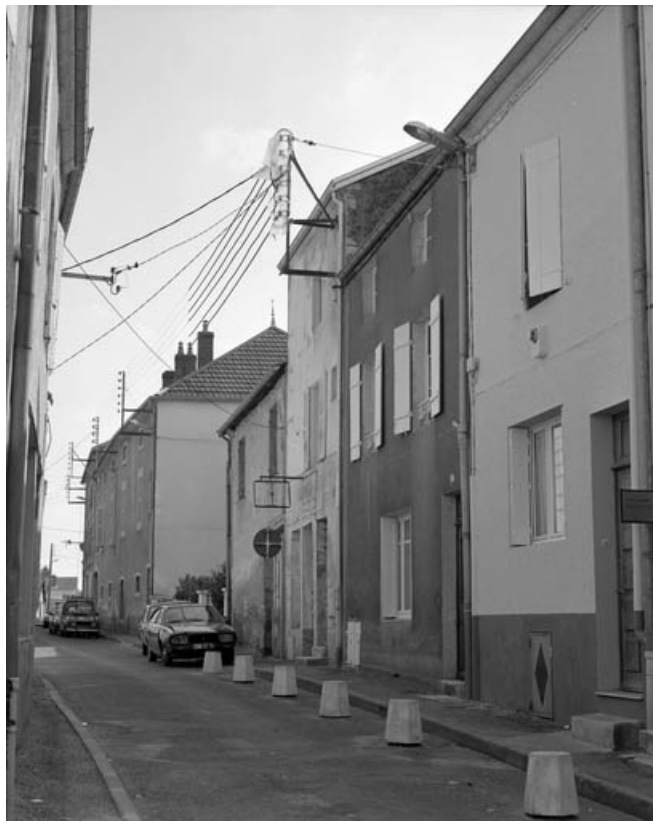
Vue de la rue de Belfort.
