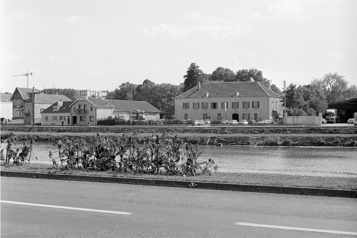
Vue d'ensemble depuis le quai Villeneuve. 70, Gray
