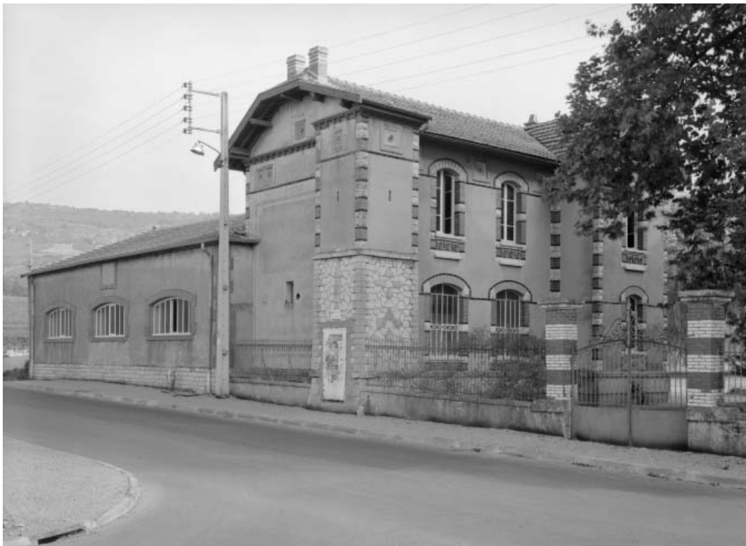
Bâtiment de la source Carnot.
