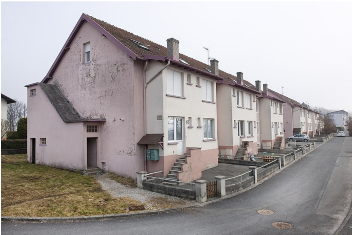
Immeubles d'habitation vus depuis l'ouest.
