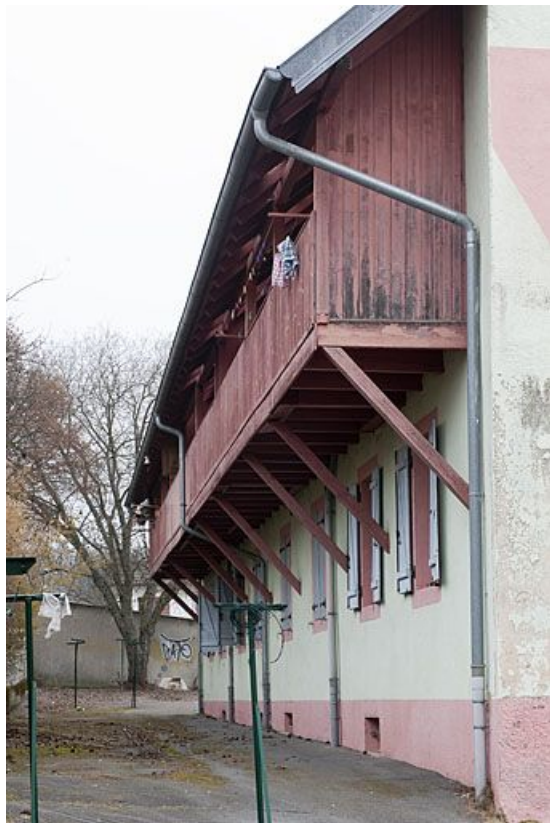
Façade postérieure de l'immeuble de 10 logements.
