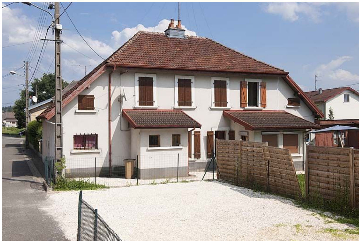
Façade ouest d'une maison.
