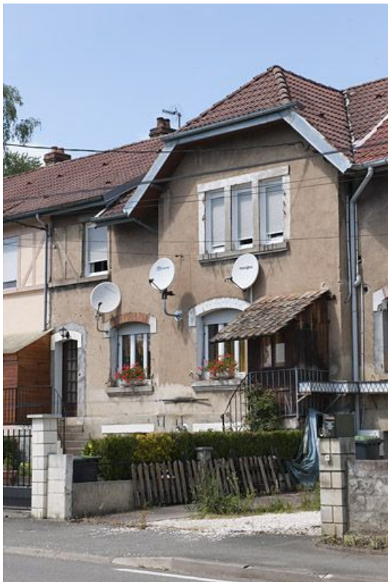
Logement ouvrier P. Détail de la façade.
