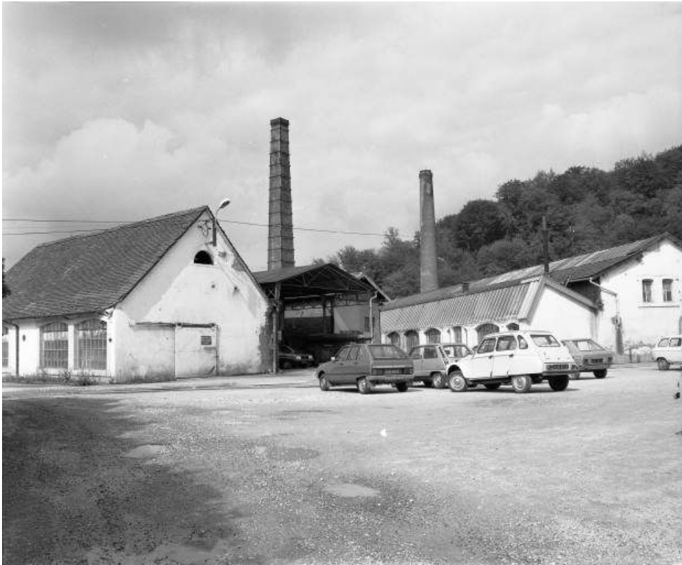
Ateliers de fabrication depuis l'est en 1981.
