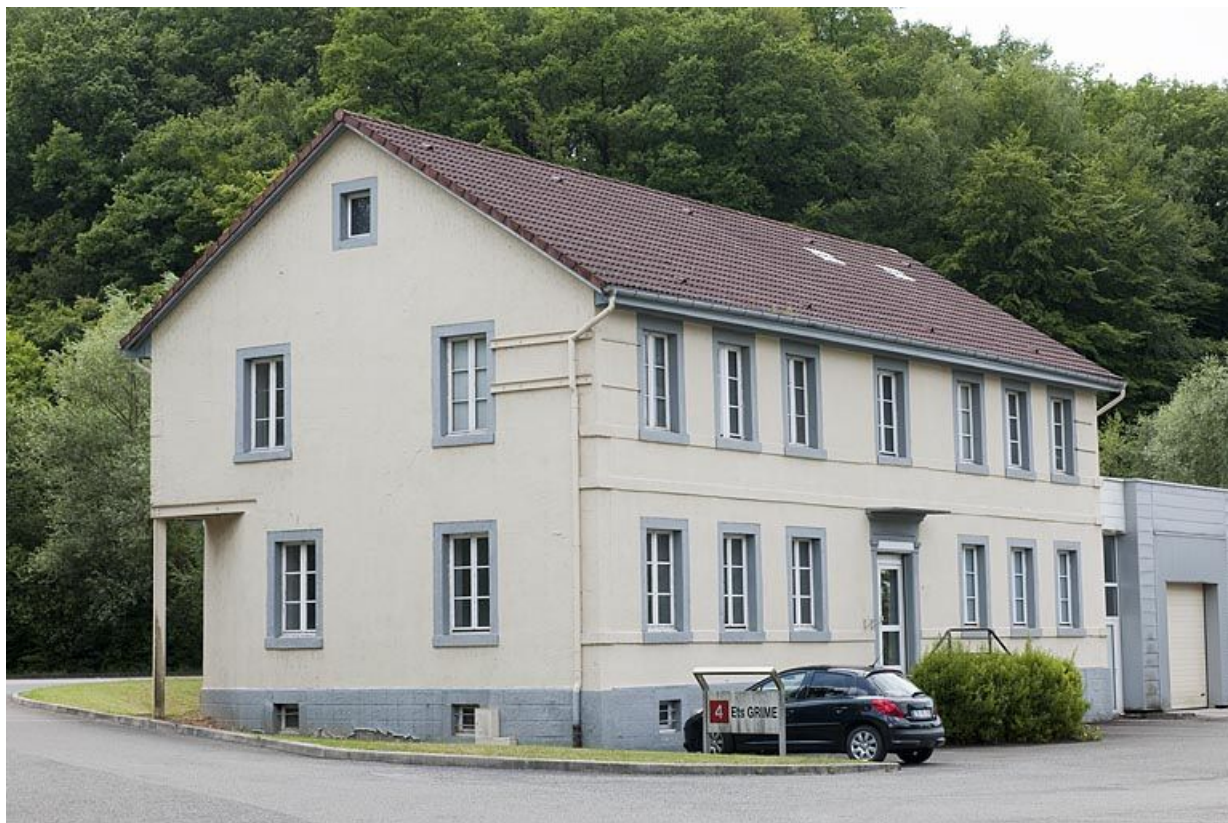
Ancien bâtiment des bureaux. Façade nord.
