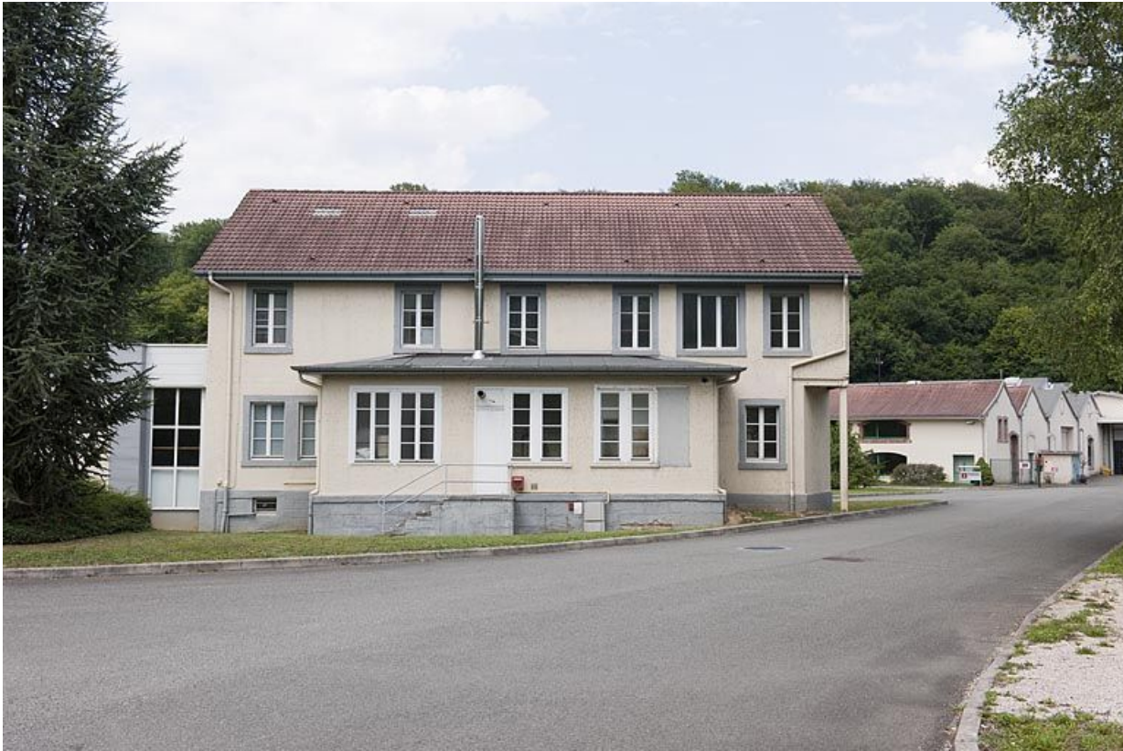
Ancien bâtiment des bureaux. Façade sud.
