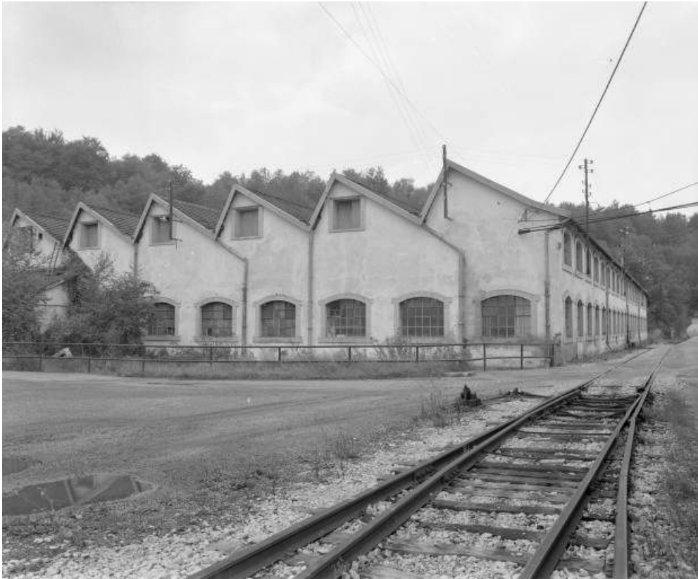
Vue rapprochée de l'atelier des pompes en 1981.
