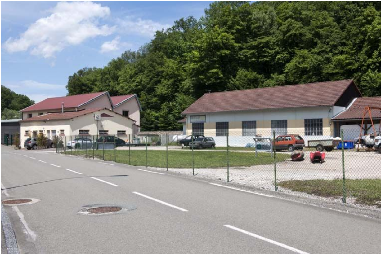
Vue rapprochée depuis le nord-ouest.
