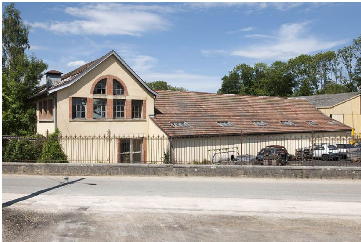
Atelier de fabrication (emboutissage, décolletage).
