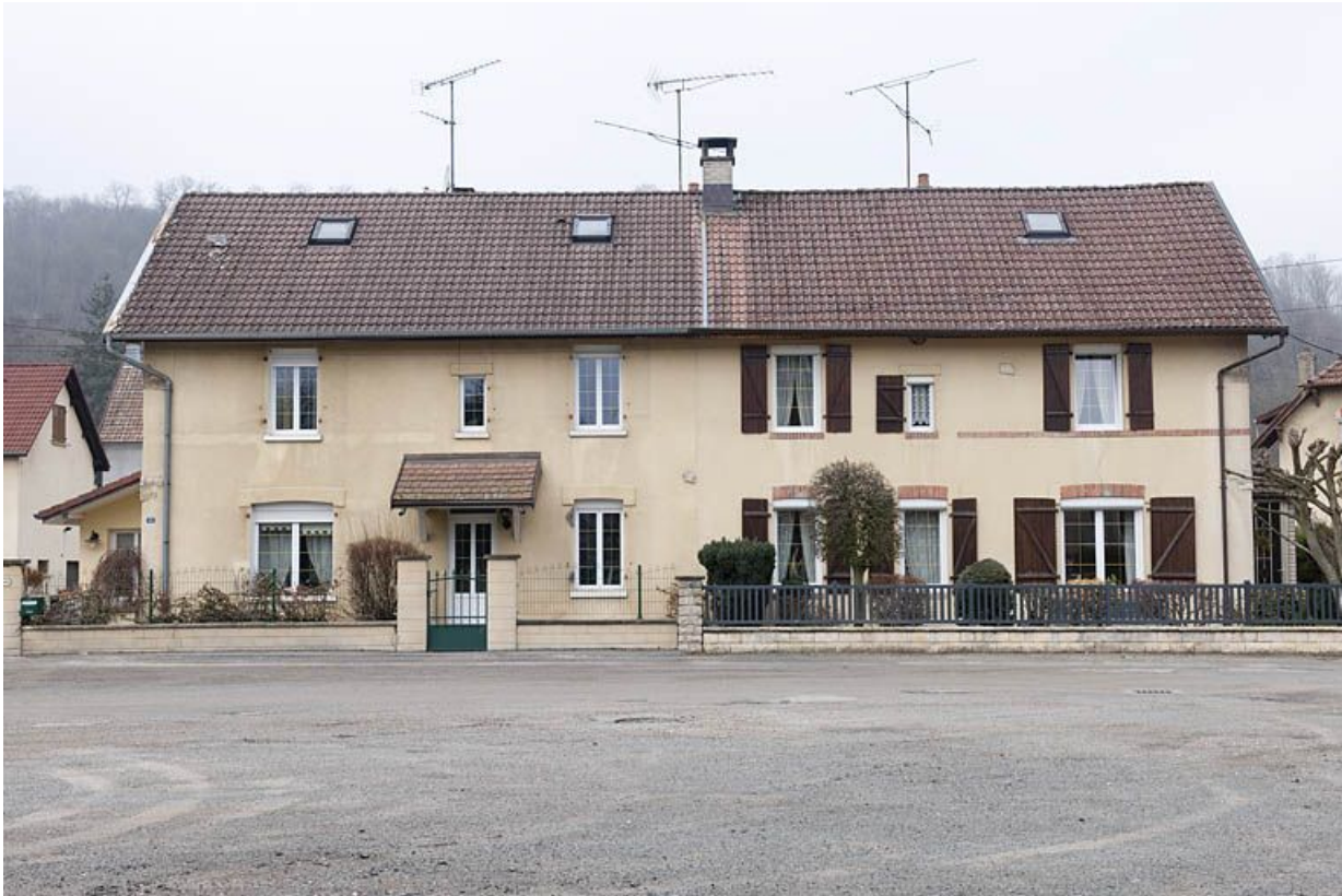
Immeuble à 4 logements. Façade est.
