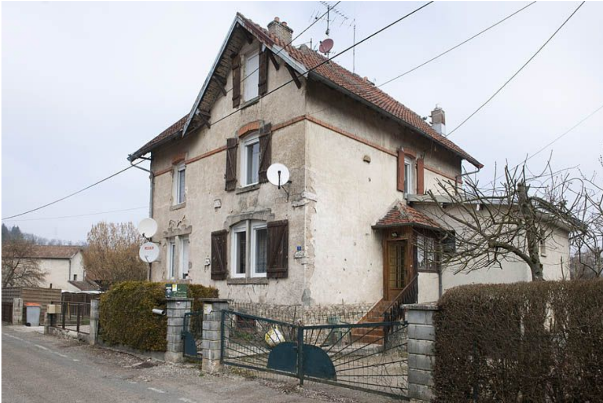
Maison à deux logements (de cadre ?).
