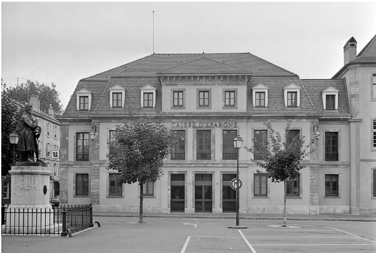
Façade nord après reconstruction.
