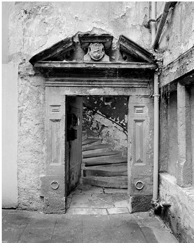
Porte de la tour d'escalier.
