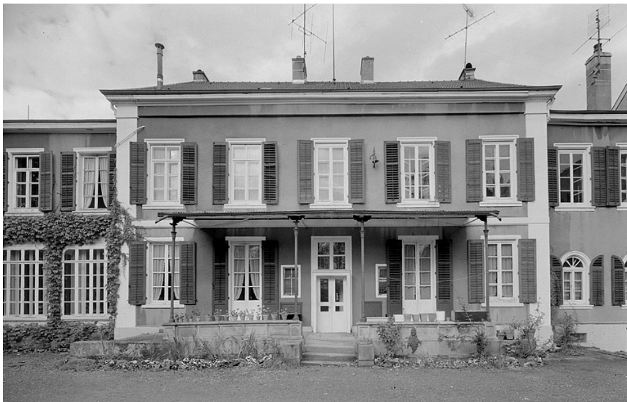
Façade sur jardin. Partie centrale.
