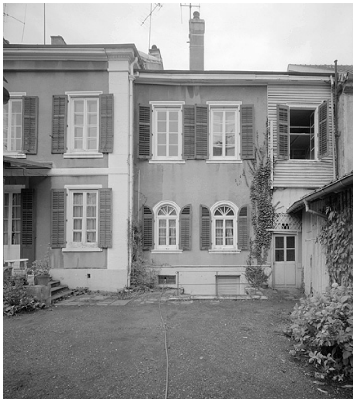
Façade sur jardin. Aile est.
