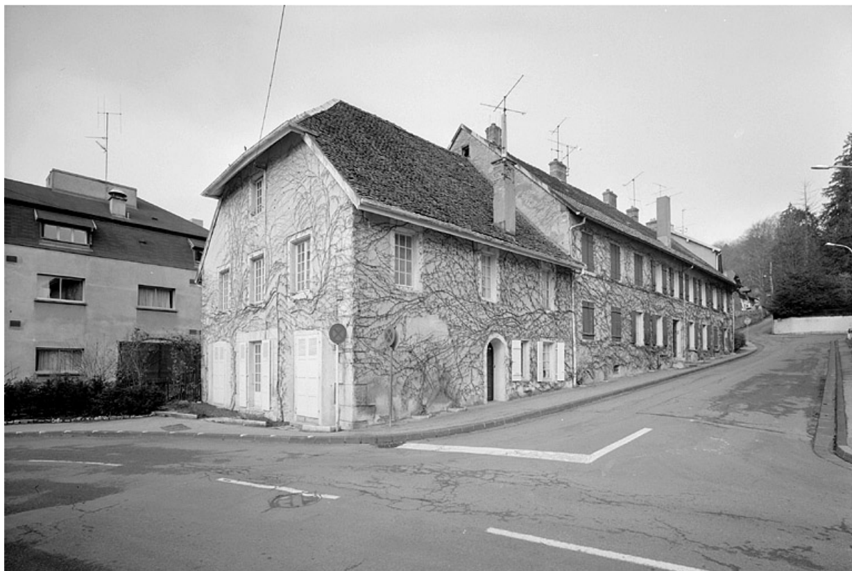
Vue d'ensemble des façades sud et est.
