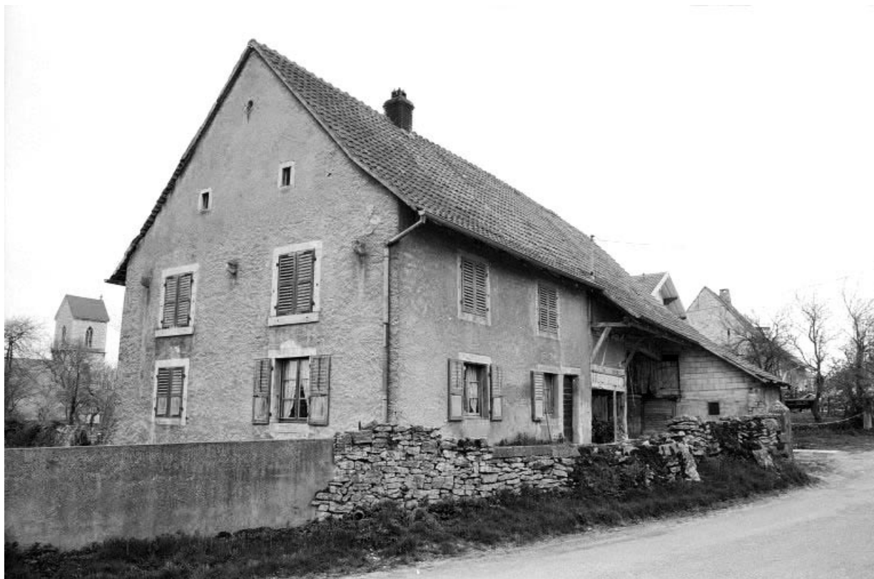
Façades antérieure et latérale gauche.
