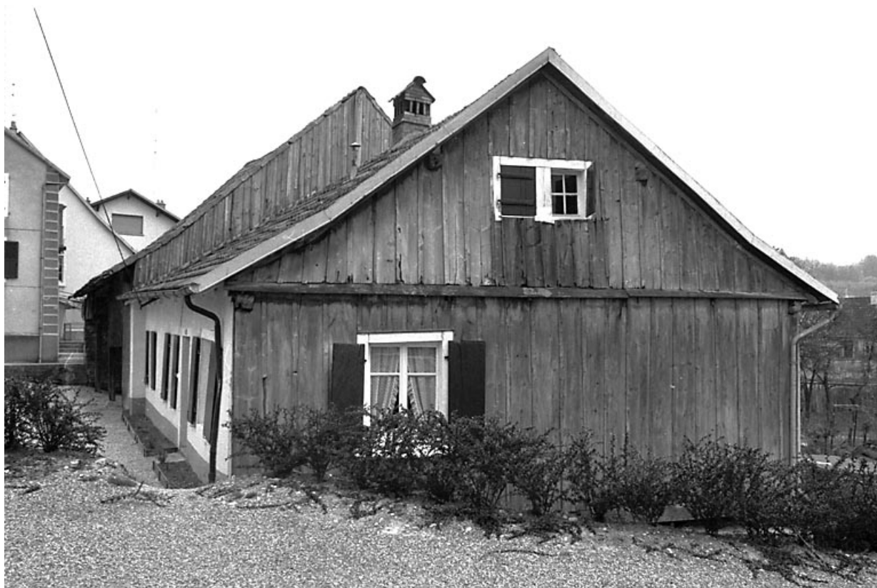
Vue du pignon droit.
