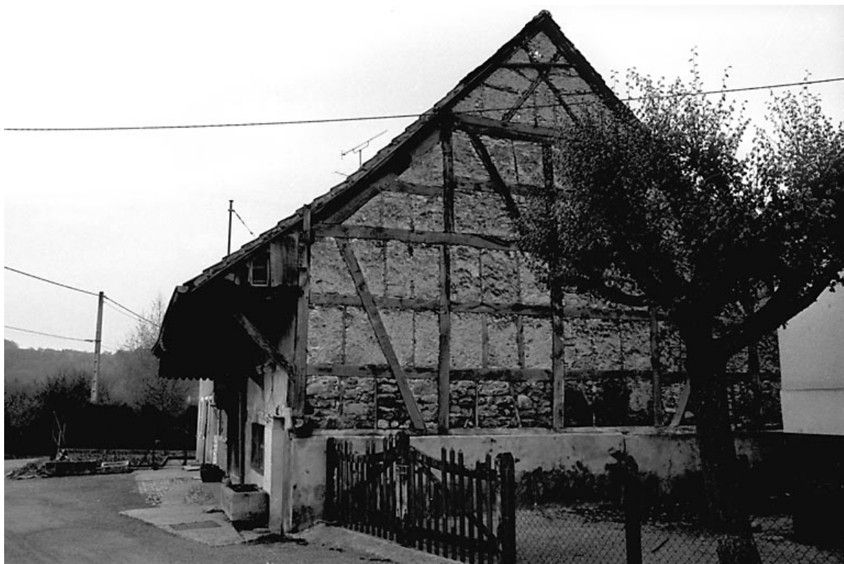
Vue du pignon droit.
