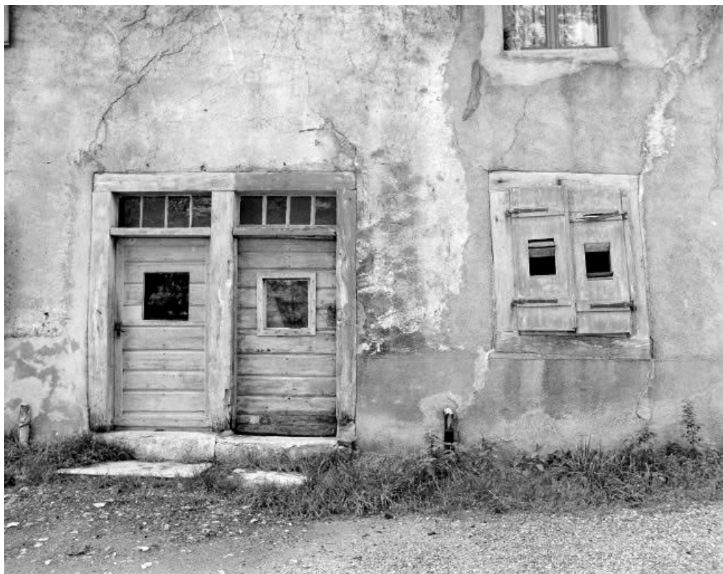
Façade postérieure : détail.
