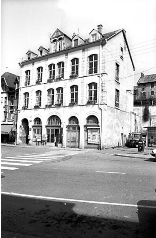
Façades antérieure et latérale droite.
