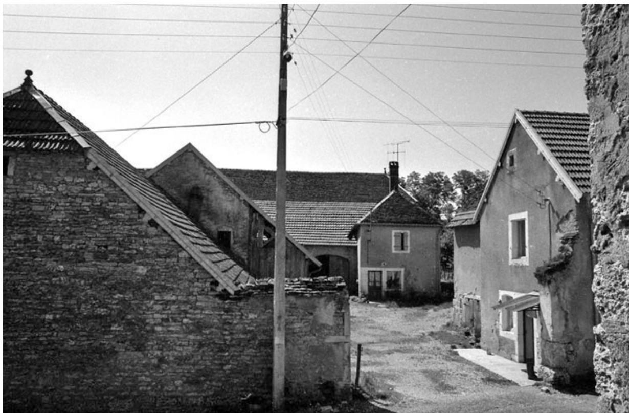
Vue d'ensemble depuis la rue.
