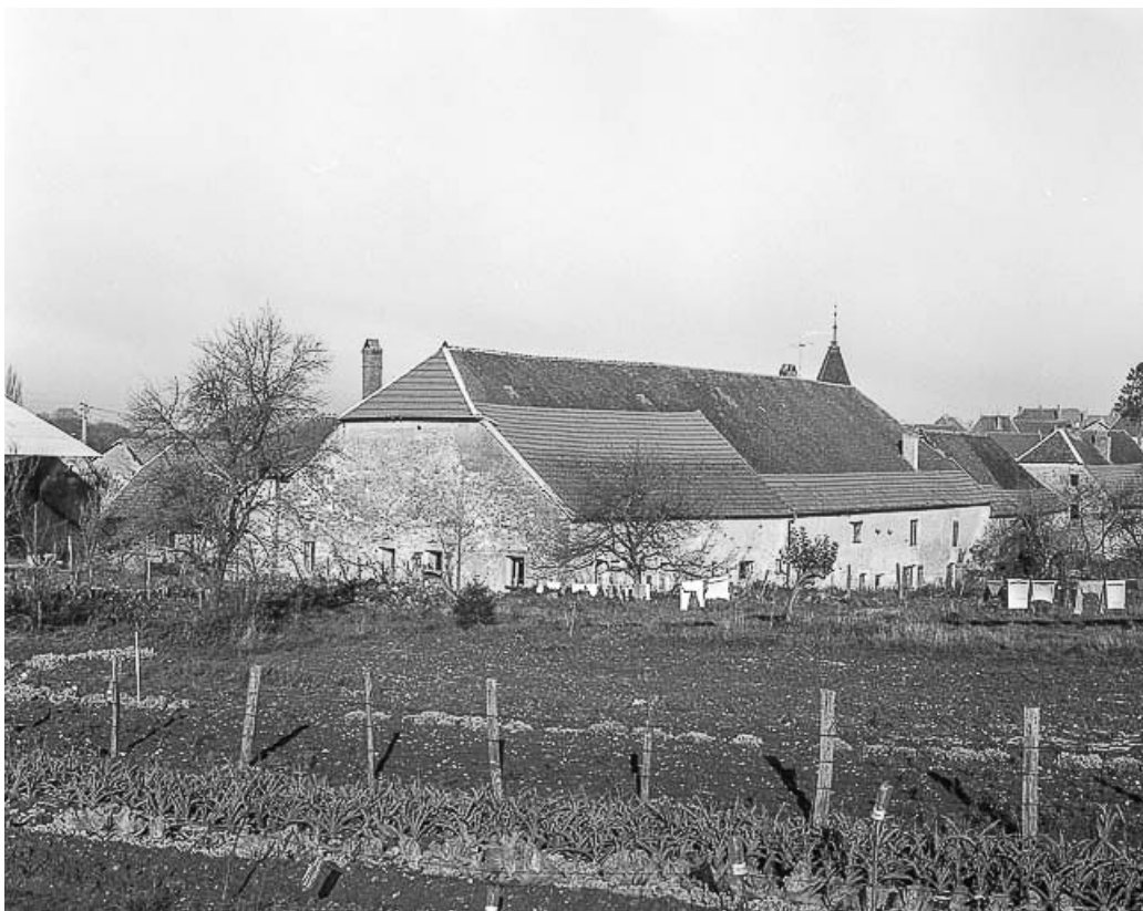
Façade postérieure : vue éloignée
