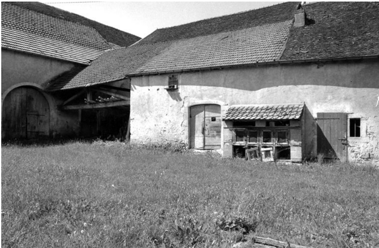
Détail : dépendances à droite dans la cour.
