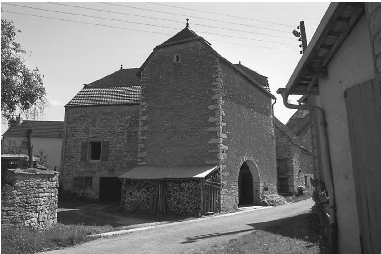
Façade postérieure du bâtiment.
