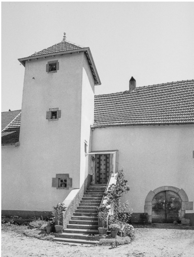
Détail : tour d'escalier et entrée de l'habitation.
