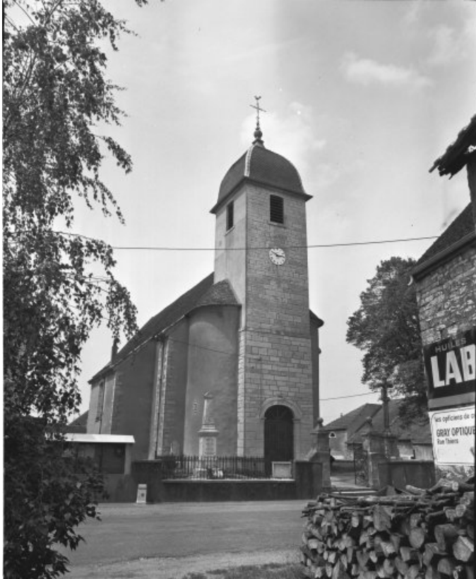
Façades antérieure et latérale gauche.
