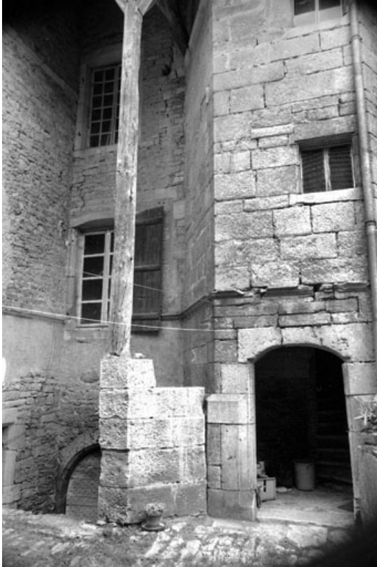
Entrée de cave et escalier en vis.
