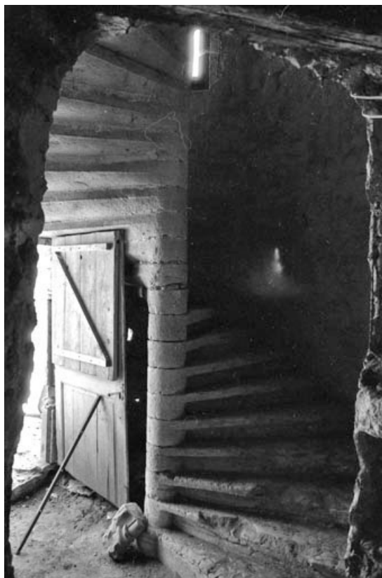
Détail : escalier en vis.
