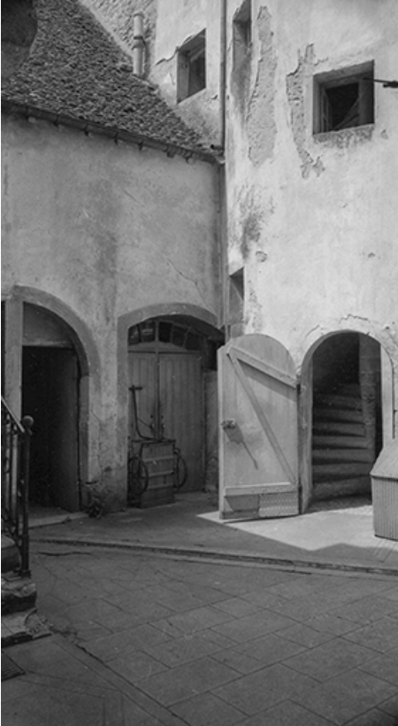
Batiments dans la cour intérieure.
