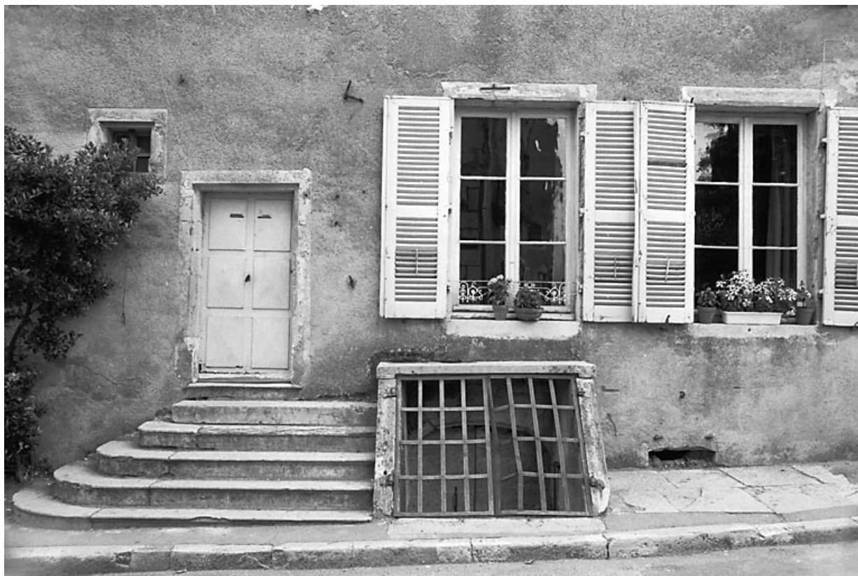
Détail du rez-de-chaussée.
