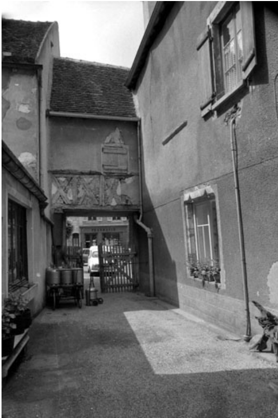
Détail passerelle couverte au-dessus de l'impasse.
