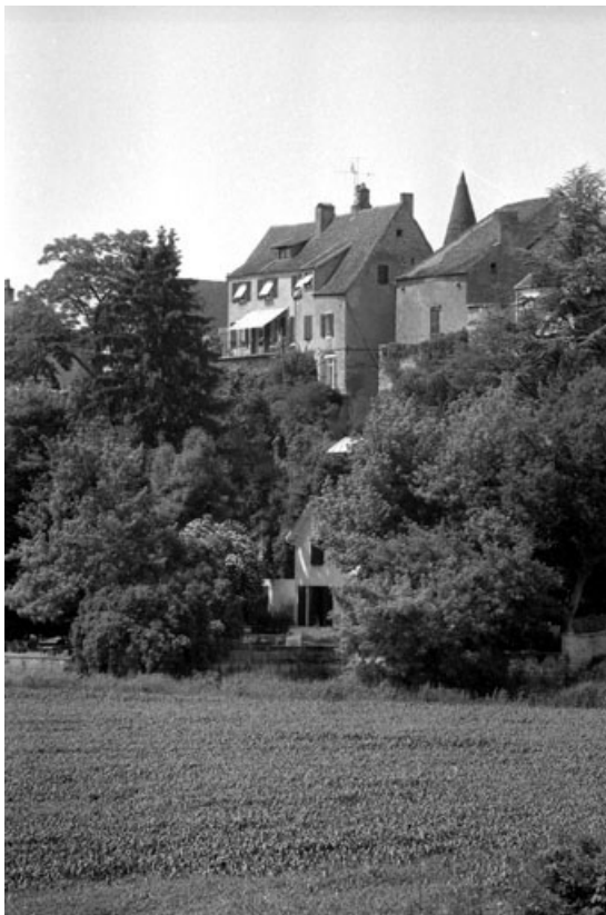
Façade postérieure, vue éloignée.
