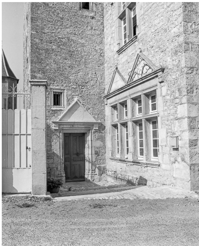
Entrée de l'escalier en vis.
