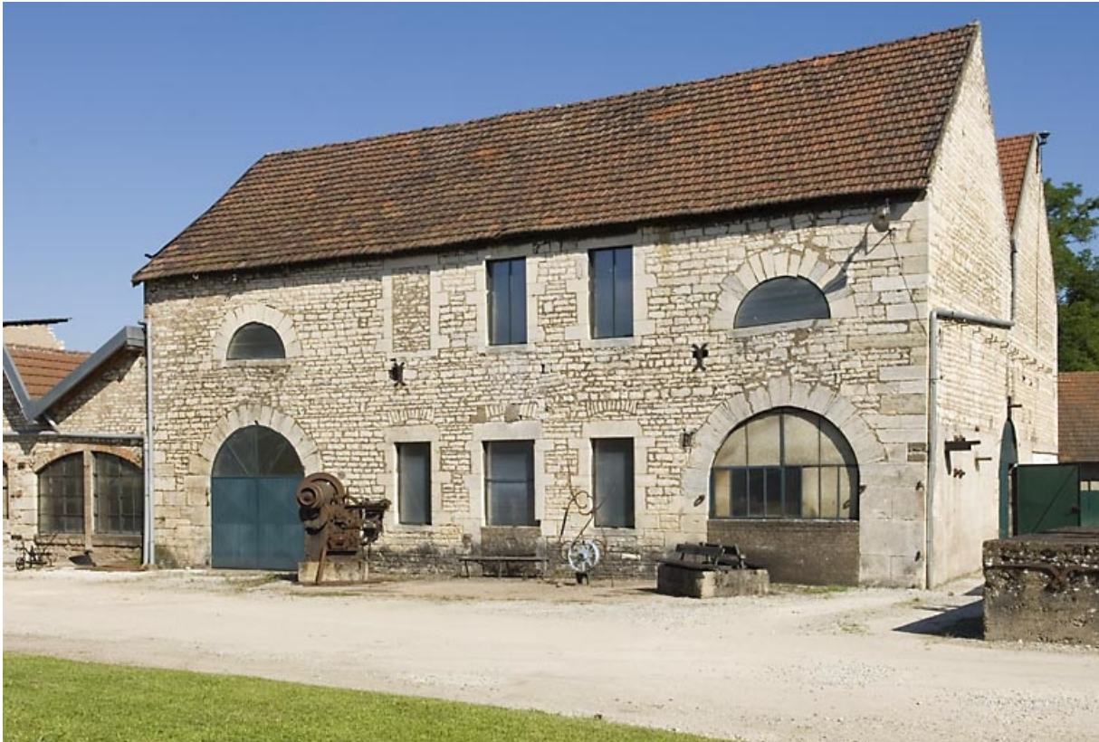
Bâtiment du haut fourneau est.
