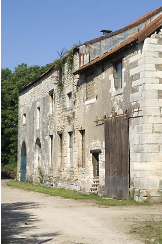
Bâtiment du haut fourneau ouest.
