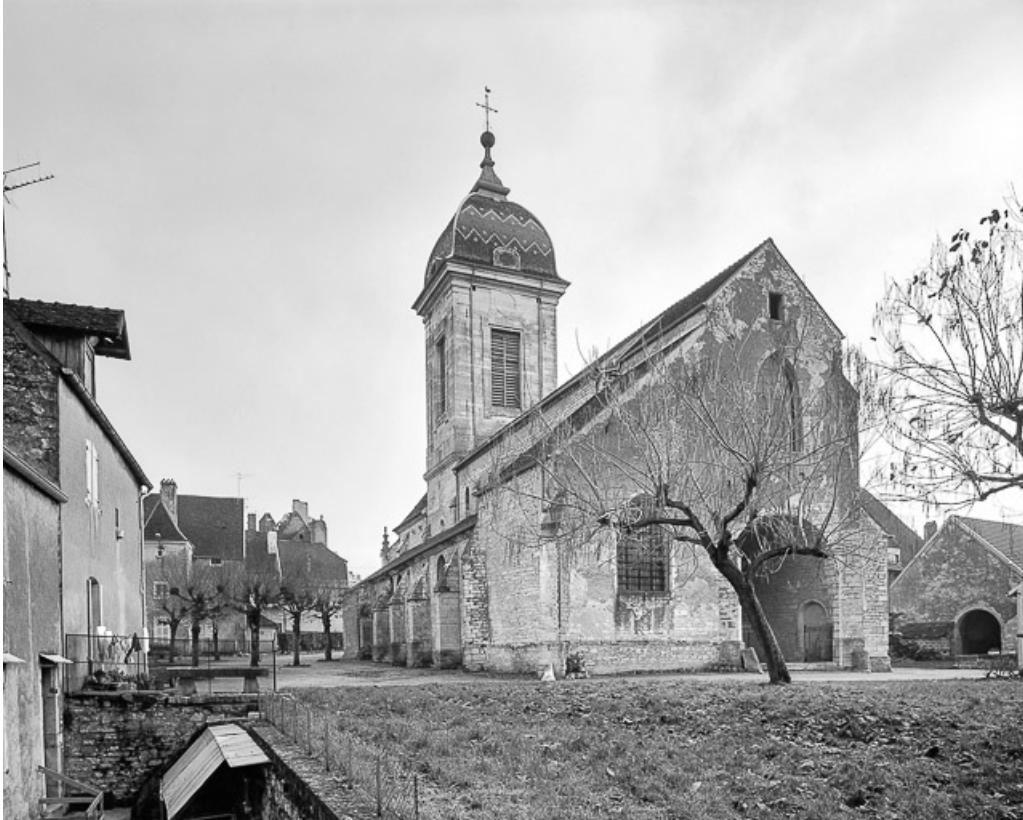
Extérieur : façade ouest.
