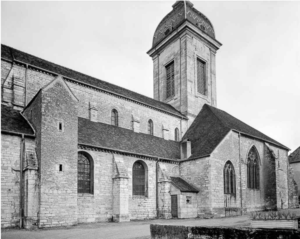
Extérieur : façade latérale sud.
