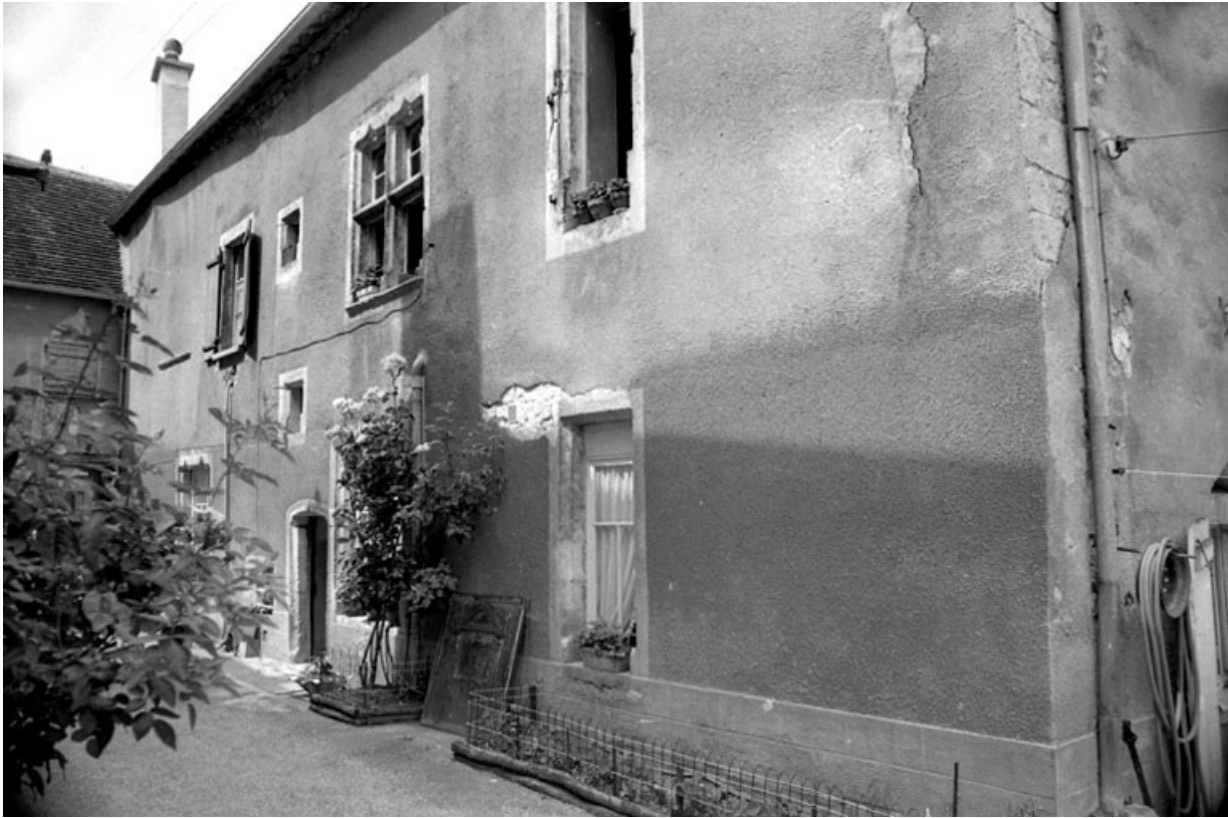
Façade sur impasse.
