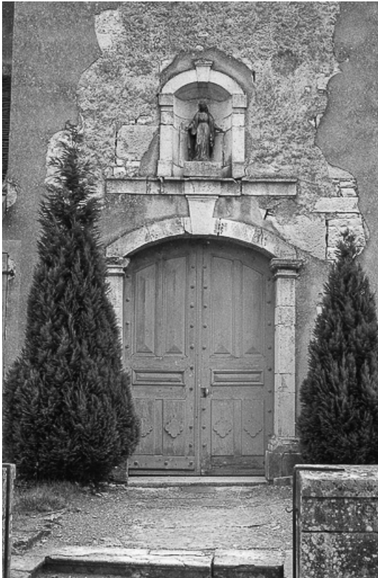
Extérieur : détail du porche de l'église.
