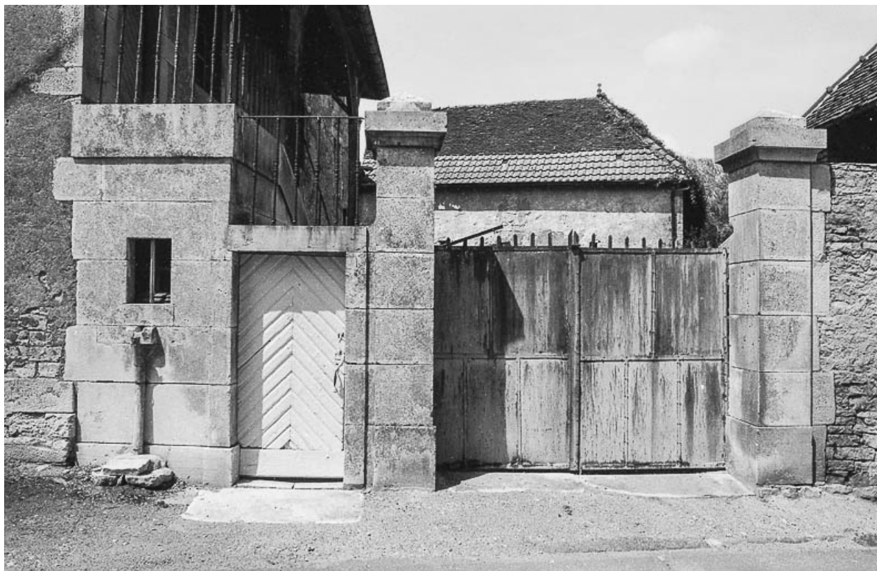
Vue rapprochée du portail d'entrée.
