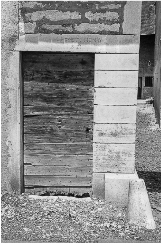
Détail : porte piétonne.
